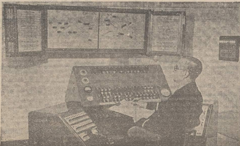
LA TABLE DE CONTROLE DE LA GARE DE CAMDEN
