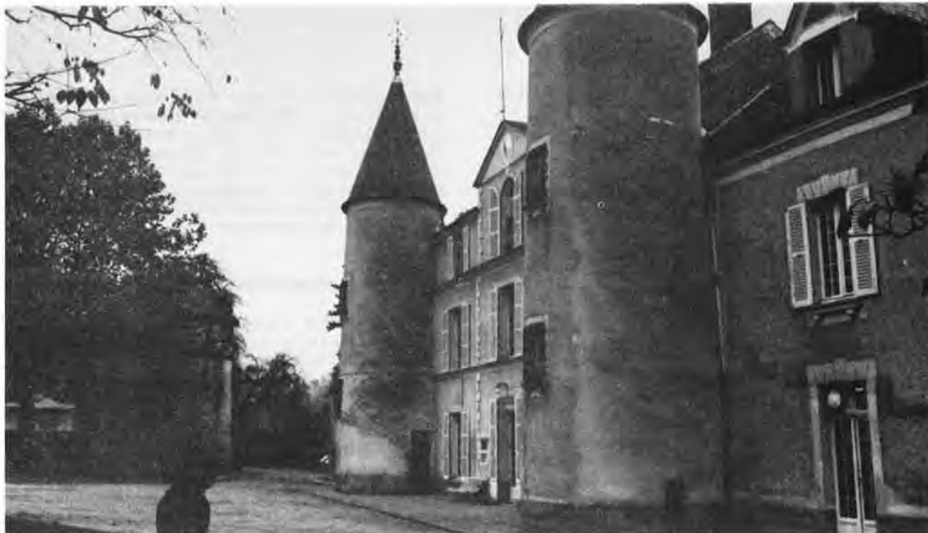
Le centre de formation CFDT de Bierville avait besoin d'être rénové.
