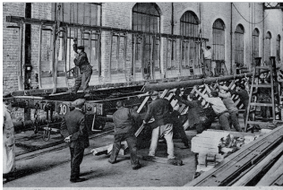
Montage en carrosserie d'une voiture P.-L.-M. C'v
